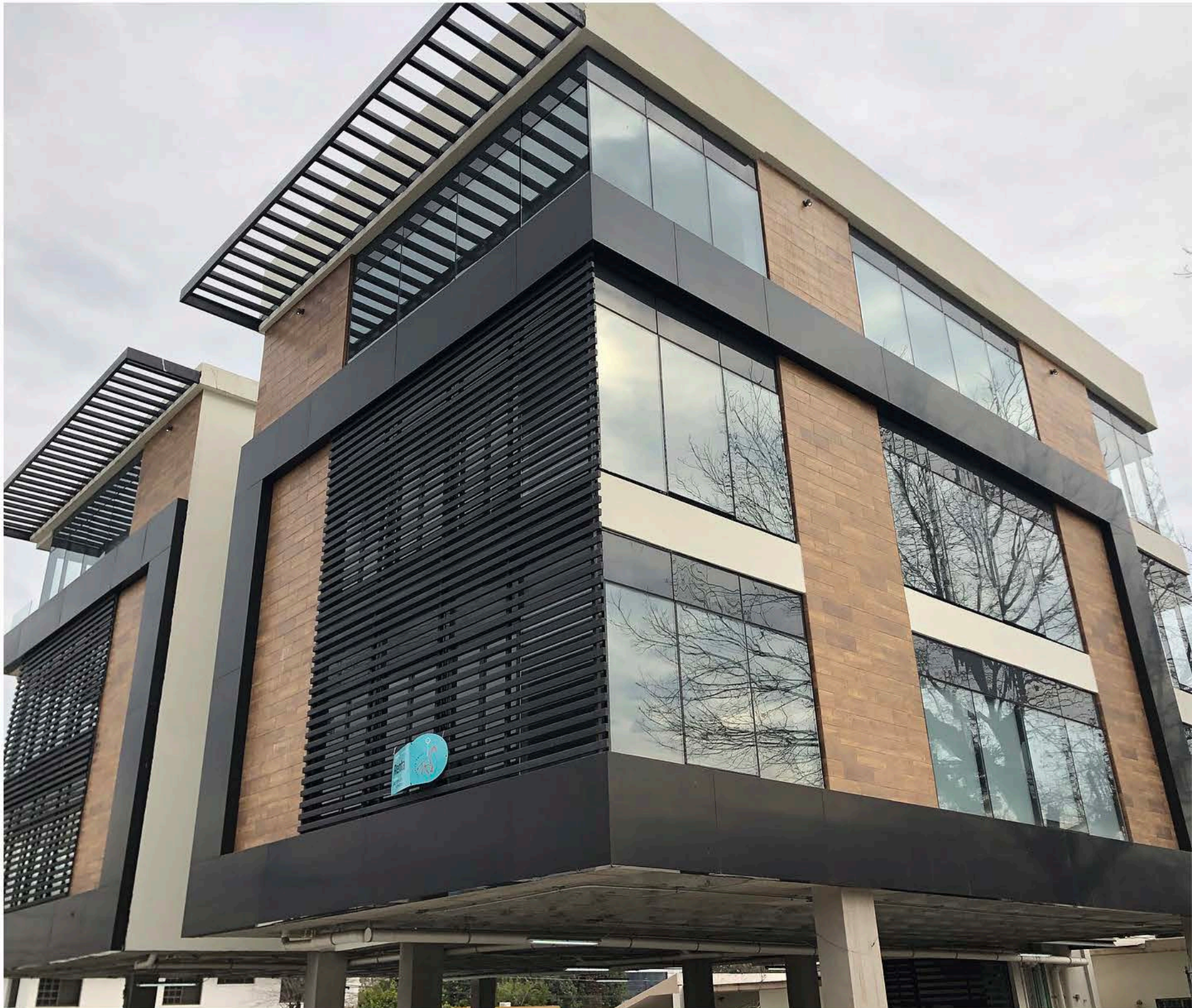
Jose Trevino Tower Chepevera, Monterrey, N.L. Cuprum MC 450 Insulated Clear Temp ¼” + Clear Temp ¼” & Aluminum Panel 11,010 sqft HW Proyectos / Azcunaga Arquitectos
